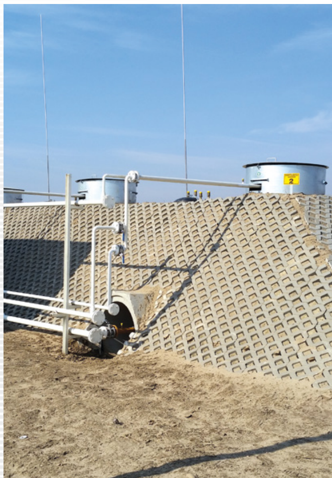
Projekt Rozlewnia gazu LPG: 3 x 50 m 3 , Ø 2500 mm
