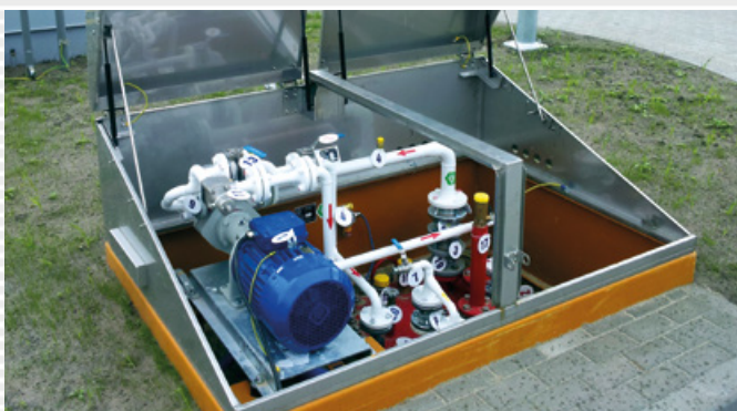
Projekt Moduł LPG na stacji paliw
