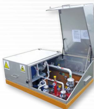
Studnia modułowa ze stali kwasoodpornej
