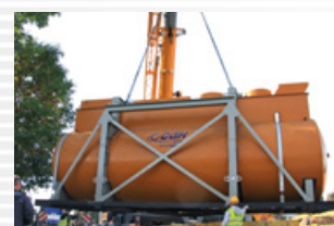
Zbiornik podziemny wielokomorowy
