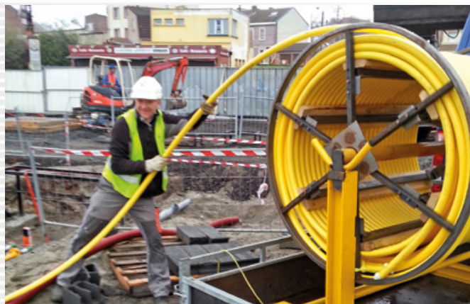
Instalacja rury LPG-FLEX
