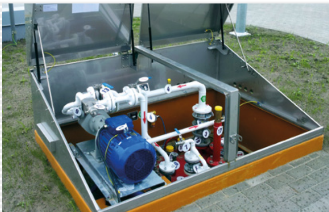
Projekt Moduł LPG na stacji paliw
